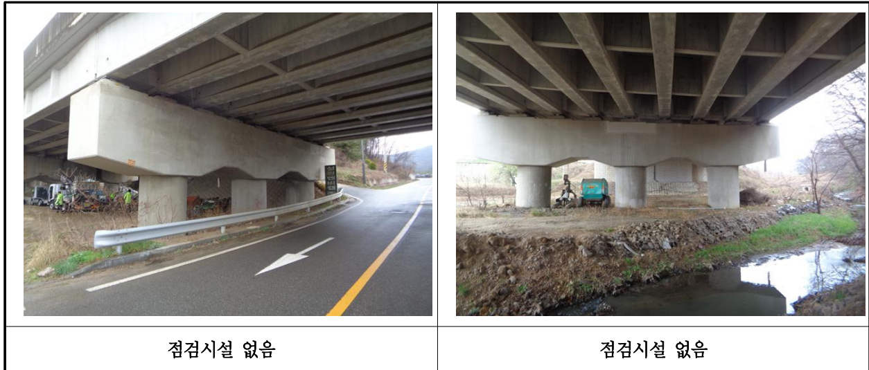
【사진 3.3.23】 교량 점검시설 전경
