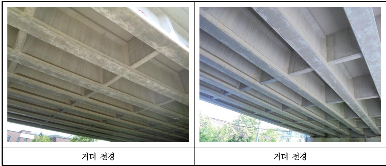
【사진 3.3.4】 거더 전경
