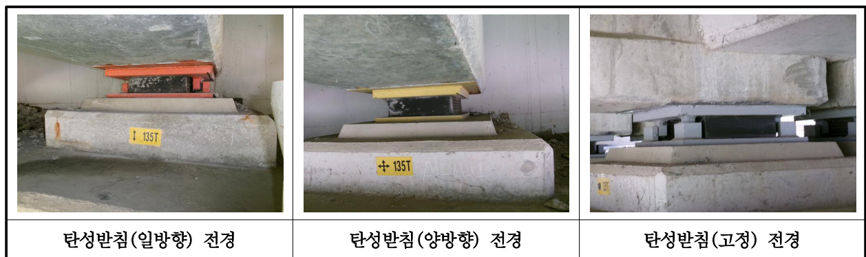
【사진 3.3.12】 교량반침 전경
