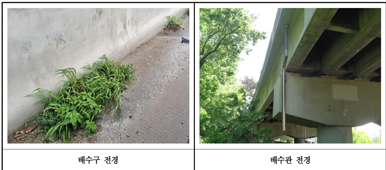
【사진 3.3.19】 배수시설 전경
