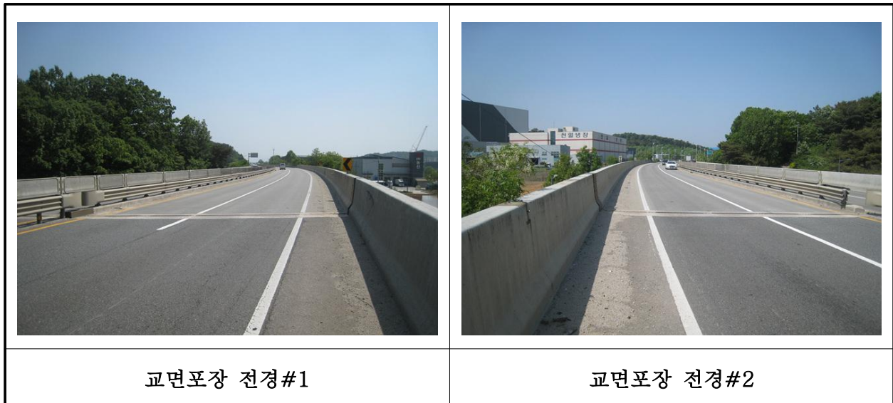
【사진 3.3.17】 교면포장 전경
