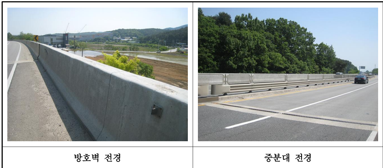
【사진 3.3.21】 난간 및 연석 전경
