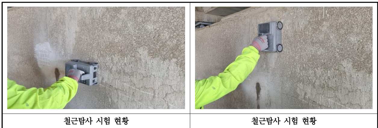
【사진 3.4.2】 철근탐사 시험
